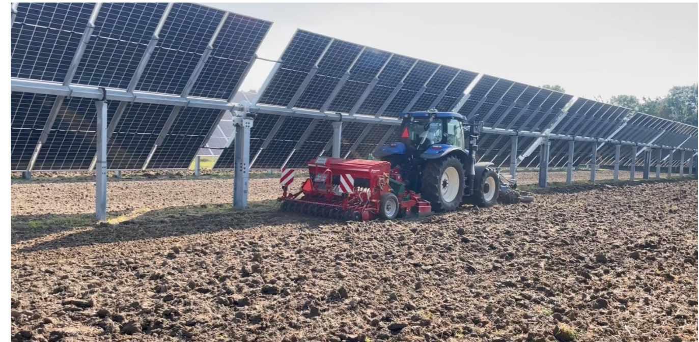
Foto: European Energy har i samarbejde med Innovationsfonden opført et mindre agri-pv forsøgsanlæg og er i proces med at undersøge synergierne mellem energiproduktion og fortsat landbrugsdrift. Det viste anlæg har en højde på ca. 5,5 meter
