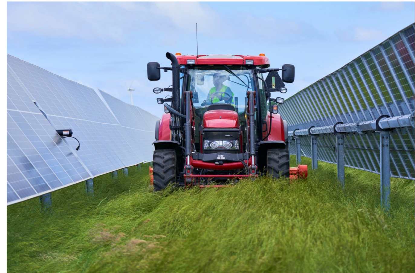
Foto: traditionelle solceller på trackerstativer giver mulighed for høst af græs. Foto fra European Energys fuldskala solcelleanlæg i 2,9 meters højde ved Harre i Skive Kommune.
